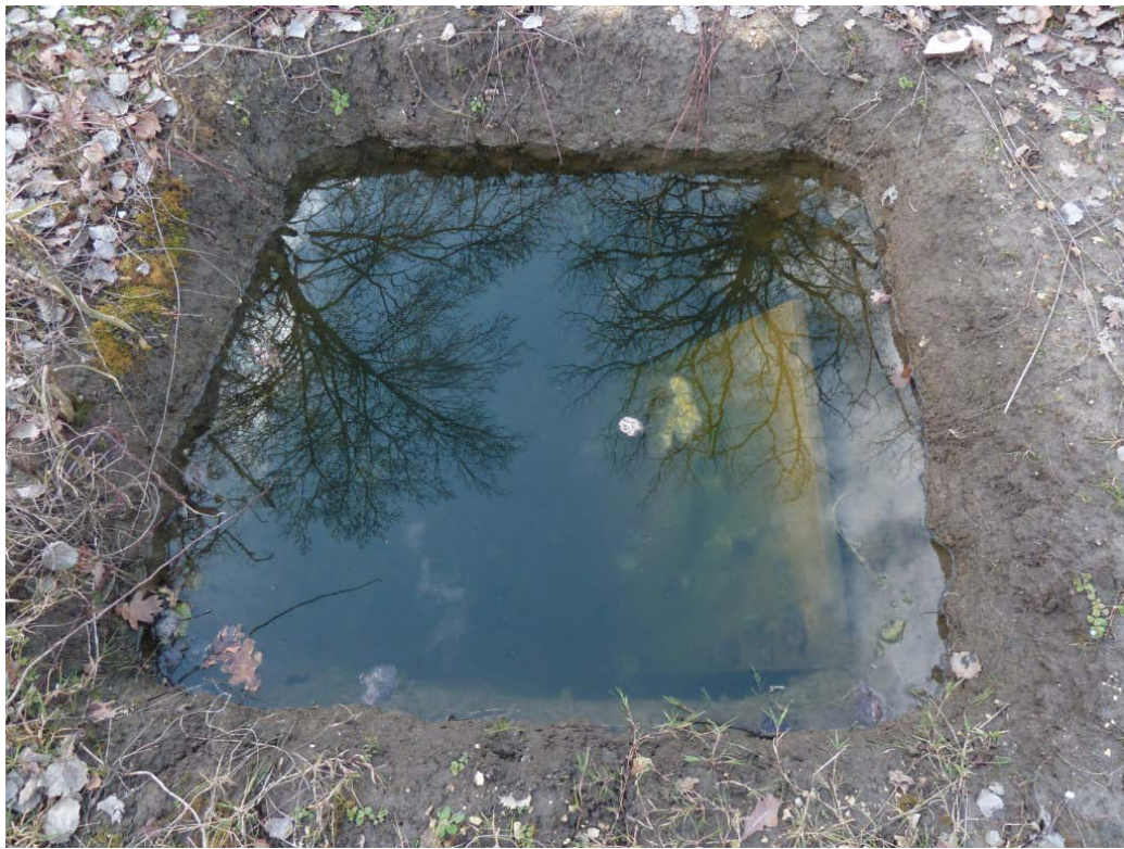
puits sans aucune protection ! ( plus d'1m X 1m sur environ 2 m de profondeur)
